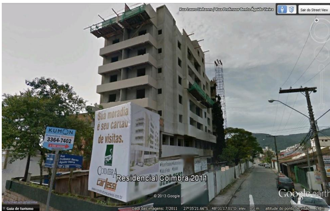
Figura 7: Residencial Coimbra em construção. Imagem de julho de 2011, obtida com o software Google Earth no módulo Google Street View.
