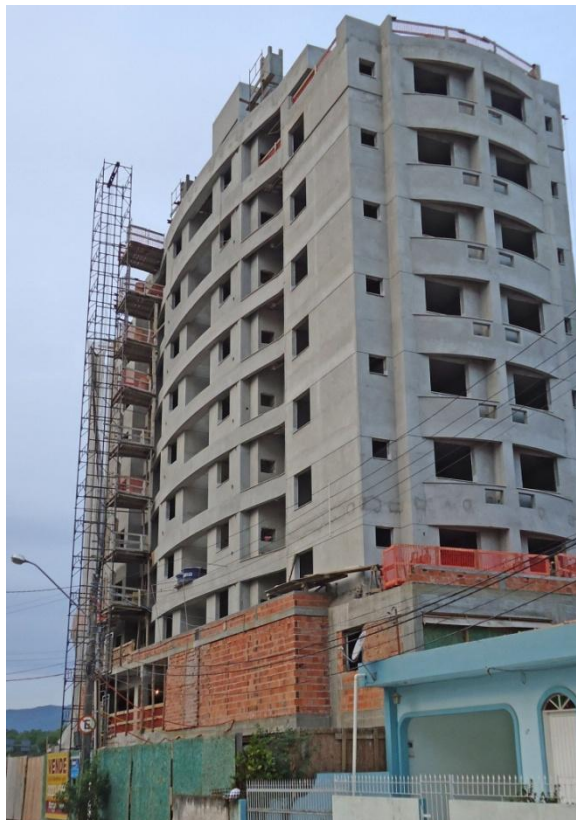
Figura 8: Residencial Adelina Darós em construção em 11 de junho de 2013. Fonte: arquivo pessoal.
