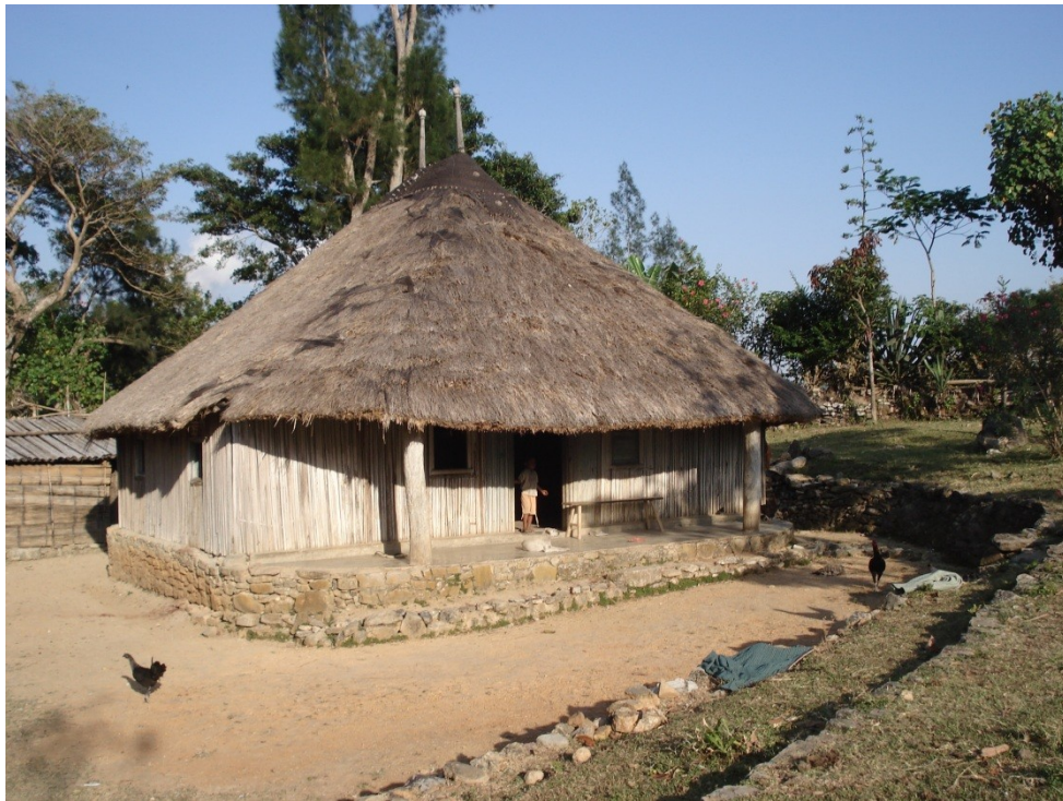
Foto 10 – Moradia retangular. Fonte: Maurício dos Santos.
